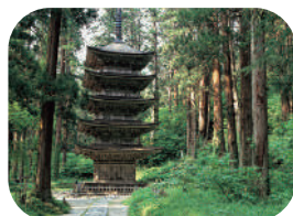
羽黒山 五重塔(鶴岡市)
