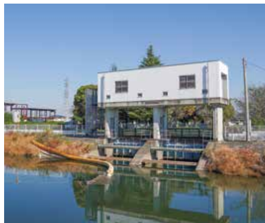
騎西領用水（新川用水）取水口と元枳橋
