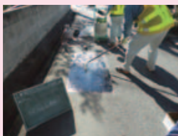
補修作業の様子
