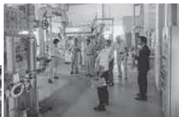
北川辺排水機場
