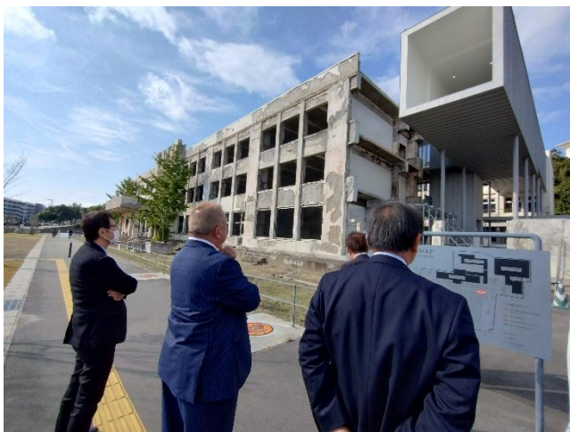
門脇小学校外観（津波火災被害）
