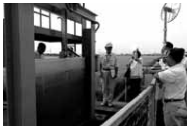
電動化された第2雨水幹線水路鋼製堰(礼羽地区)
