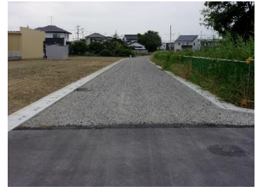
※ 区画街路6-76号線 築造工事 (路盤まで) 雨水管工事 (R6)
