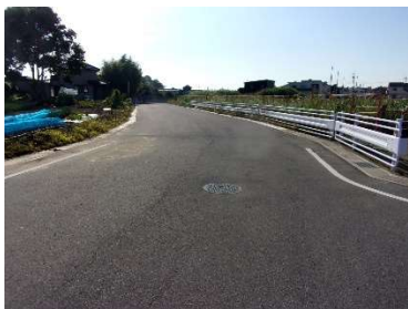
※区画街路9-5号線築造工事
