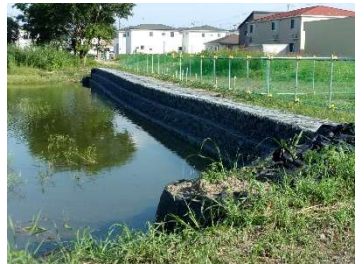
※ 区画街路6-76号線築造に伴う お谷が池護岸整備工事
