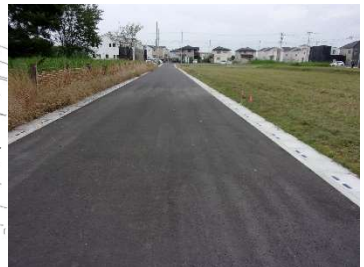
※区画街路6-81号線築造工事
