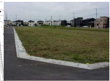
※ 107街区整地工事 (R5年度) 使用収益開始 (R6年度)
