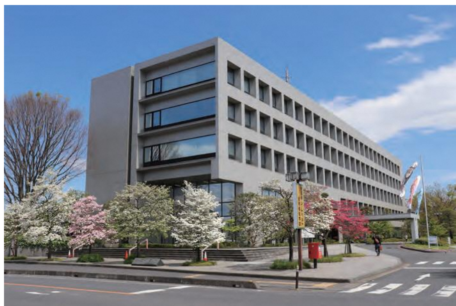
加須市役所本庁舎
