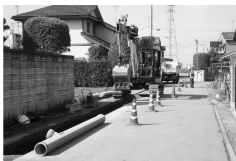
下水道管渠工事
