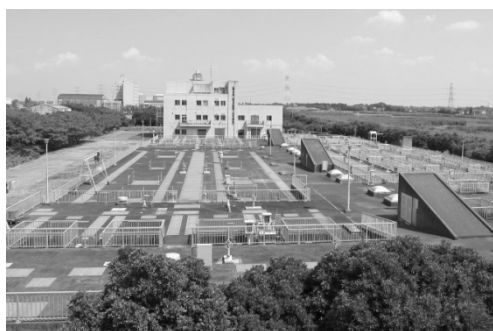
加須市環境浄化センター全景
