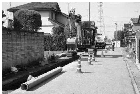
下水道管渠 かんきょ 工事
