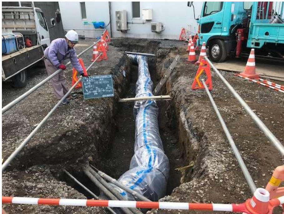
写真 3-1 浄水場内配水管の耐震化工事
