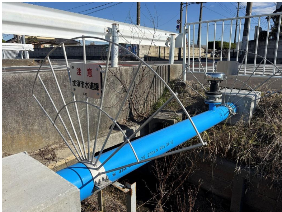
写真 1-1 市内の水道管
