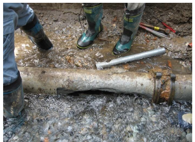
写真 2-1 老朽化した水道管破損による漏水の状況(平成20年)
