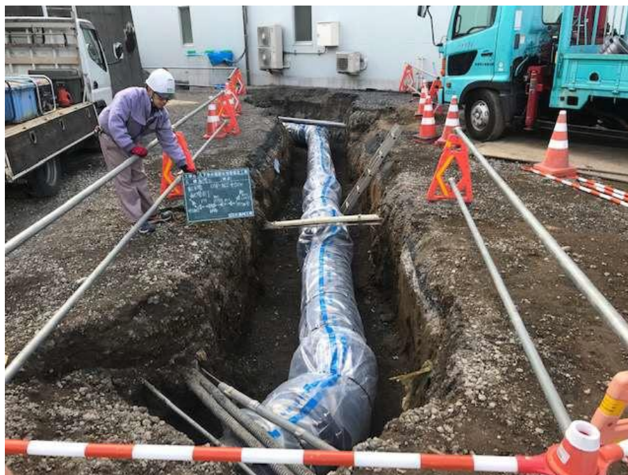
写真 3-1 浄水場内配水管の耐震化工事
