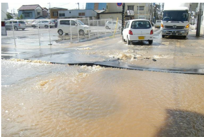
写真 2-1 老朽化した水道管破損による漏水の状況(平成20年)
