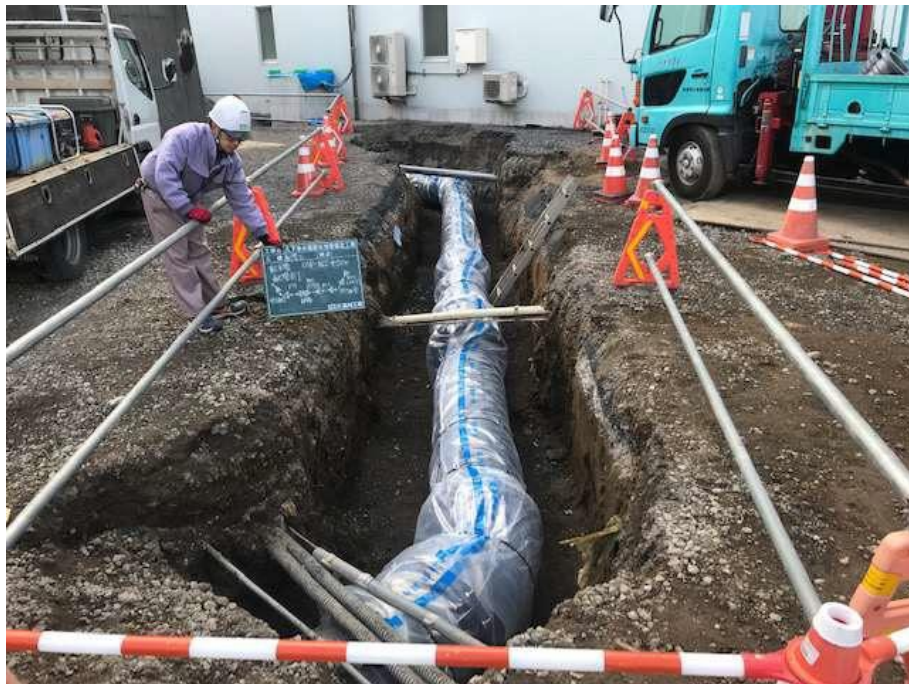
写真 3-1 浄水場内配水管の耐震化工事
