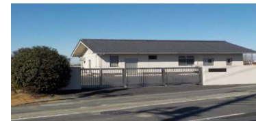
【 農業集落排水処理施設 】
