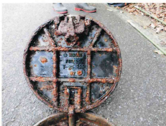
(マンホール蓋裏状況 S-3)
