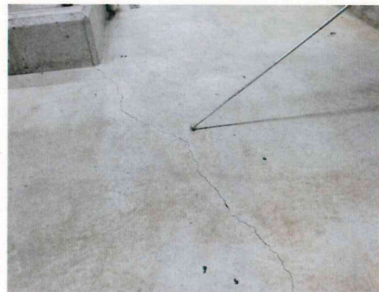
汚泥ポンプ室床面
