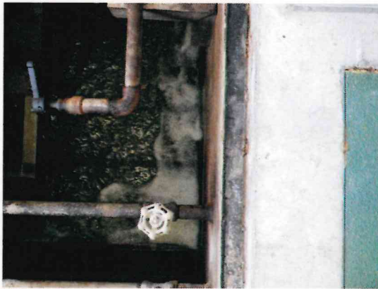
ばっ気沈砂槽
