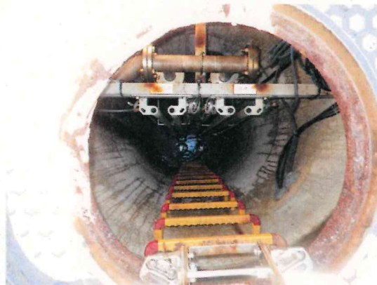
(マンホール内ポンプ状況)
