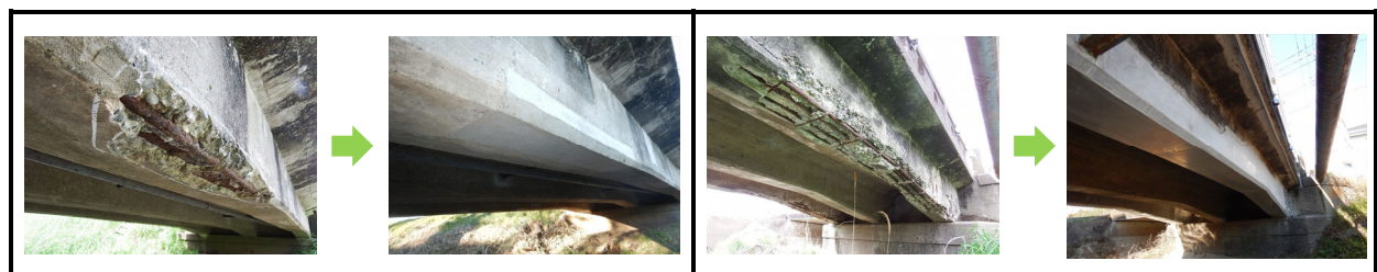
主桁 断面修復(加 石橋 4010)
