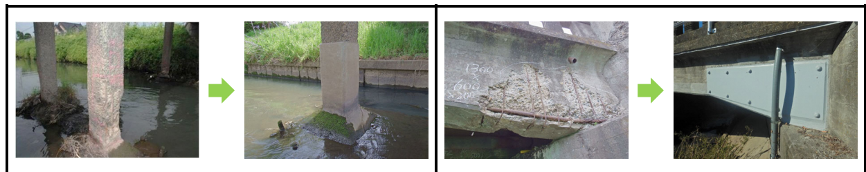
橋脚 RC 巻き立て(大 板橋)
