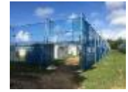
防風ネットの設置
