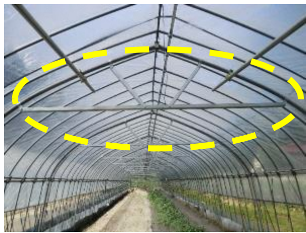
タイバーの設置による補強
