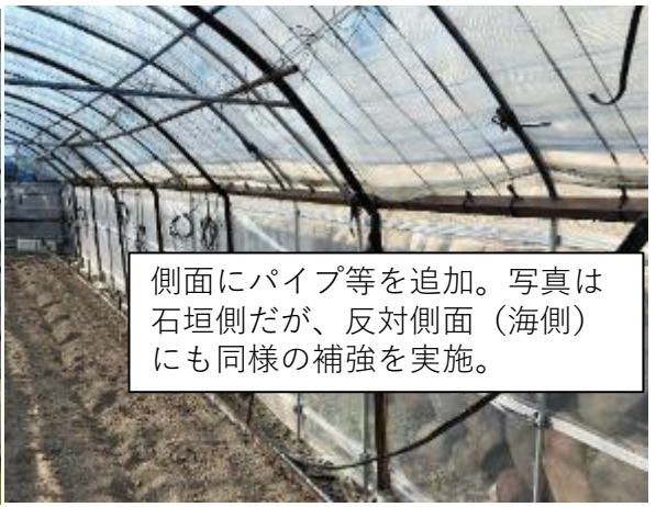
側面の補強（強風対策）
