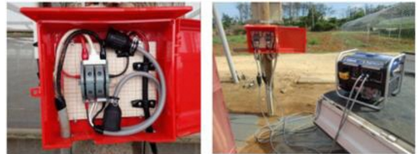
非常用電源ボックス及び非常用発電機の接続
