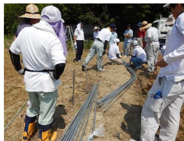
災害復旧の取組実証
