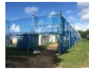
防風ネットの設置
