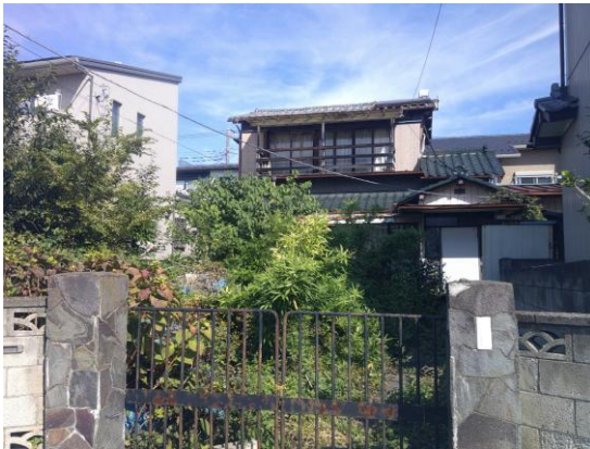
雑草や庭木が生い茂り、お隣の敷地や道路にはみ出している
