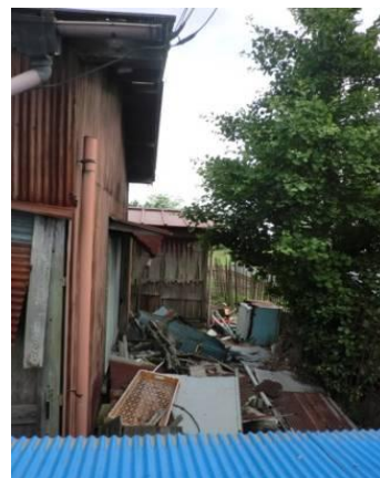
敷地内にごみ等が散乱している。
