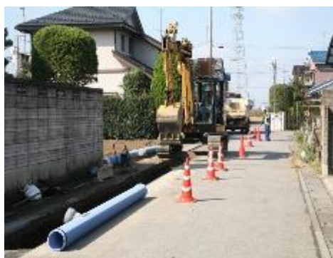
下水道管理設工事
