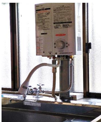
麺打ち室内に新設した給湯器
