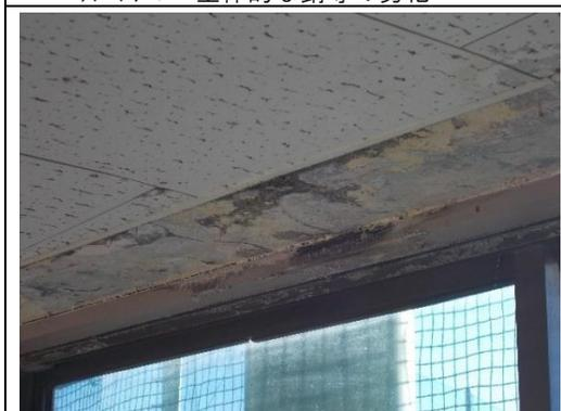
管理棟：雨漏りによる内装の腐食等劣化
