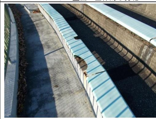
管理棟上段観覧席：樹脂製座面の破損等劣化
