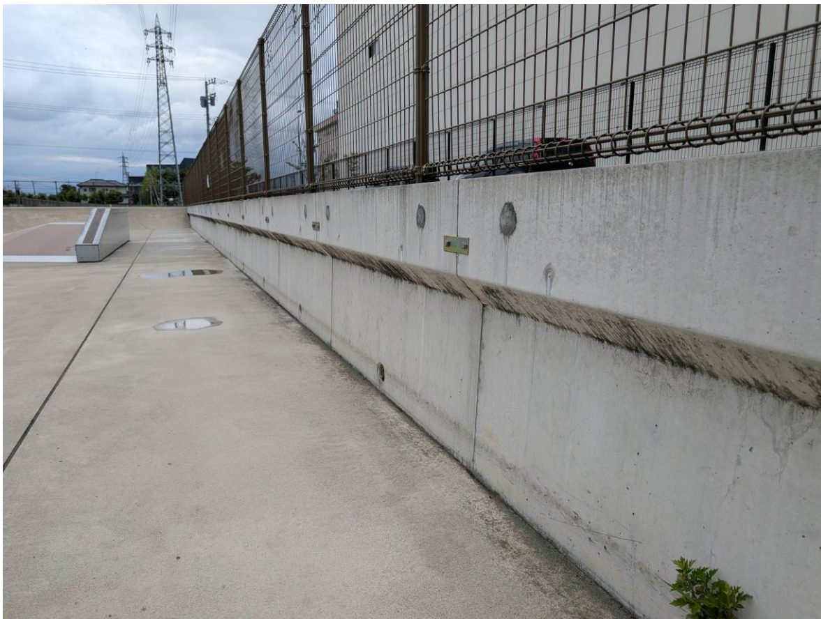
④ スケートボードエリア内西側壁面 a
