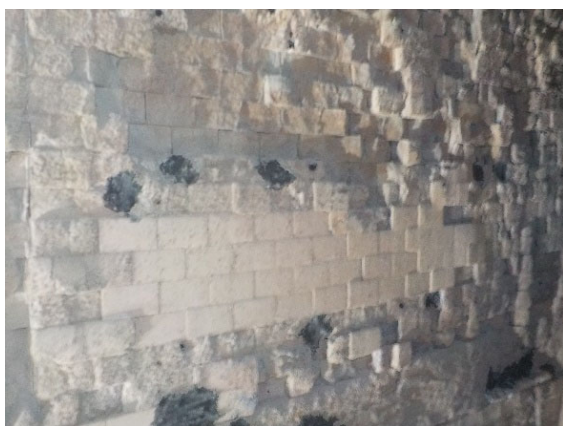
焼却炉炉壁(内部)
