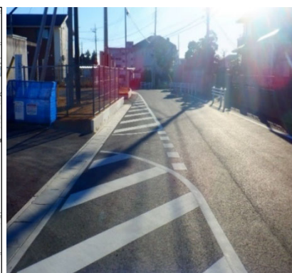
[工事後の市道 249 号線]
