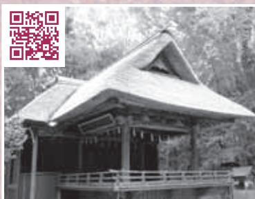
修復後の玉敷神社神楽殿 (騎西552-1 玉敷神社境内)
