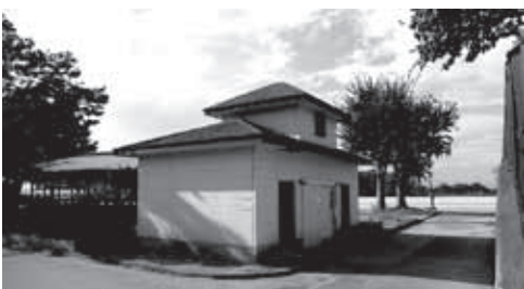
改造工事対象トイレ
