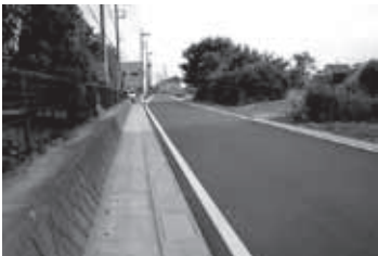
事業により改良された道路の例
