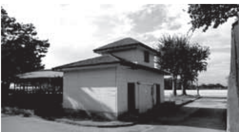
改造工事対象トイレ
