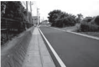
事業により改良された道路の例
