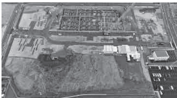
埼玉県済生会加須病院建設工事現場の様子 (10月7日現在)
