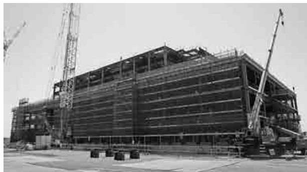
工事が進む埼玉県済生会加須病院 (4月20日現在)
