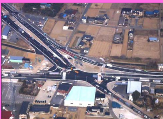
高速道路と産業団地を結ぶ国道整備
